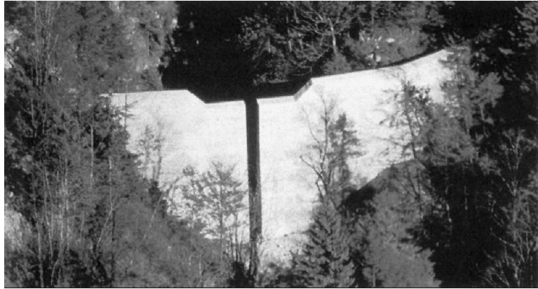
Gambar 3. Cek dam tipe Slit (Sumber : Armanini dan Larcher, 2001)
